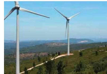
Au Portugal, l'une des 7 éoliennes de ce parc est située à 158 m d'un important gîte d'hibernation (environ 4 000 Miniopterus schreibersii et 150 Rhinolophus ferrumequinum ). La vitesse de vent de démarrage de cette éolienne a été augmentée à 5 m/s en octobre, novembre, décembre, mars et avril. © J. Rydell
