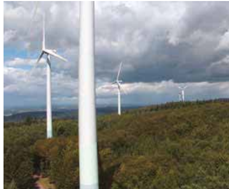
Parc éolien en Forêt Noire (Allemagne). Une population locale de Pipistrelle commune ( Pipistrellus pipistrellus ) a été affectée par ces éoliennes, ainsi que des espèces migrantes telles que la Noctule de Leisler ( Nyctalus leisleri ). © H. Schauer-Weissahn & R. Brinkmann
