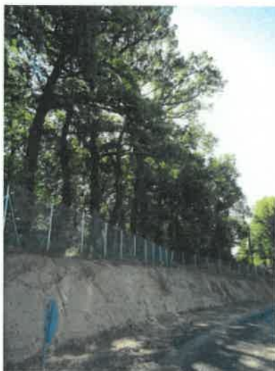
Terrassements avec talus très abrupt en discordance avec le relief environnant
